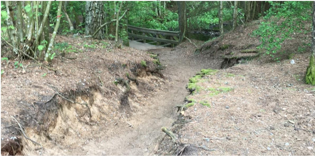
Västra nedgången till bron över Kårsbyån. Källa Motala kommun
