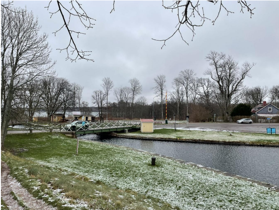
Figur 5: Bro över kanalen och slussstrappan vid Borenhult norr mot Boren (Foto M. Kristoffersson, 2026)
