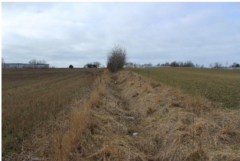
Figur 6 Ej vattenförande dike
