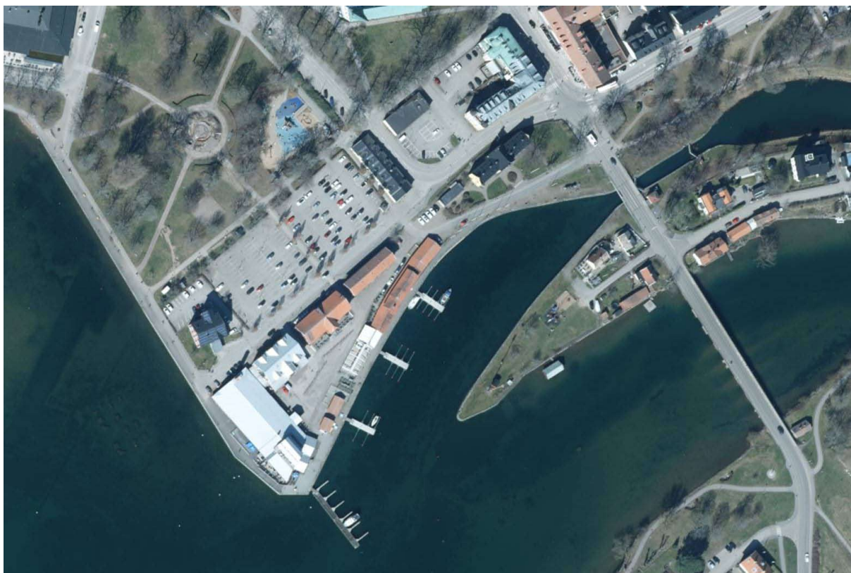
Flygfoto från 2023. Silon har rivits och ersatts med en nya byggnad. Flytbryggorna har förnyats. Längs kajen har bodaroch uteser- veringar tillkommit. Den södra delen av området har fått en allt tydligare karaktär av park.
