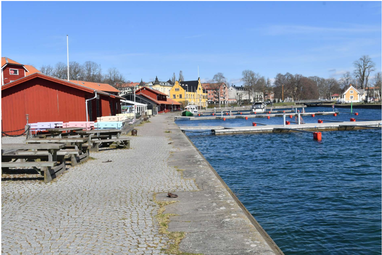
Norra kajen mot öst. Kajen är stensködd med huvudsakligen kalksten, men även delar i granit. Bodarna närmast i bild uppfördes runt år 2000.
