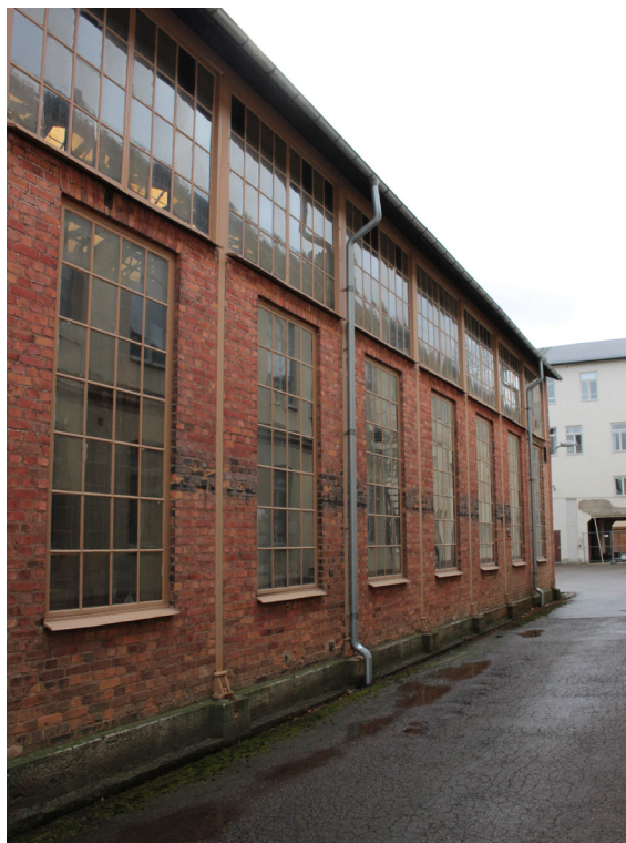
Ångpanneverkstadens västra fasad med stora fönsterytor för ljusinsläpp.
