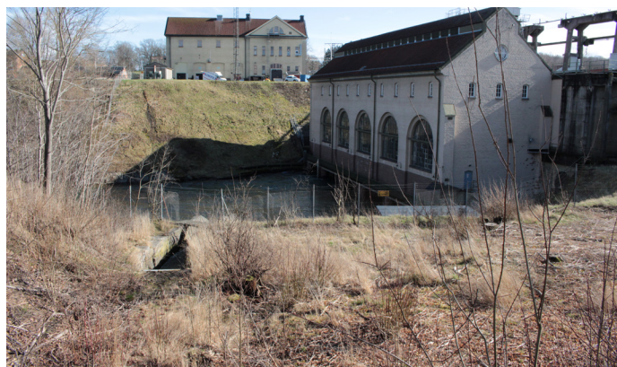
Vattenkraftverket vid Motala ström. Verkstaden hade redan från början drivits av vattenkraft med vatten från Göta kanal via en kulvert under kanalen till ett överfallshjul. En del av kulverten syn i bildens vänstra hörn.
