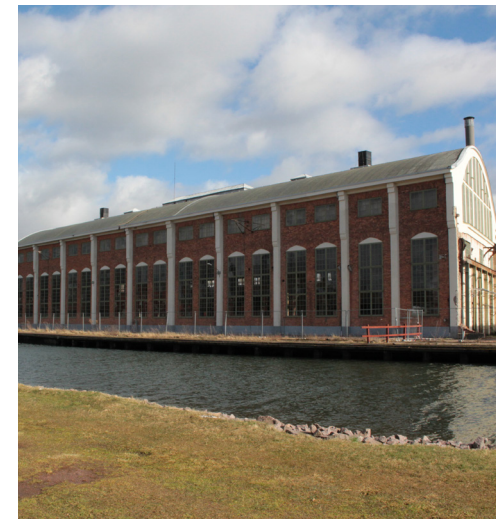
Lokhallen med karaktäristiskt rundade gavlar och repetitiv fönstersättning som säkrade ett stort ljusinsläpp i lokalen.
