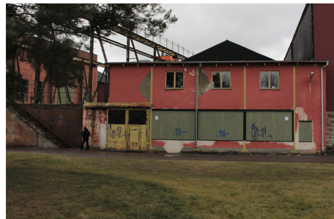
Fasaden mot öster, där järnpelarna framträder i gult.
