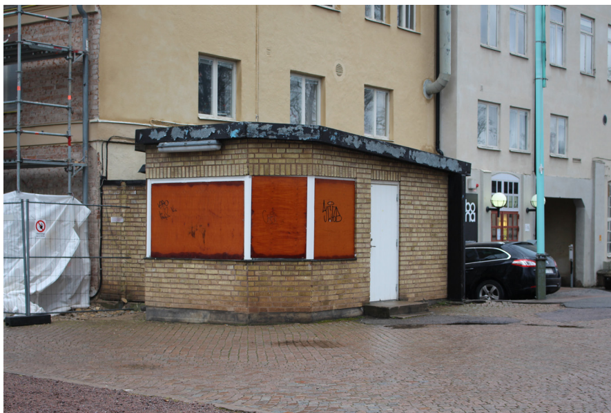
Portvaktshuset sett från sydväst. Fönstren täckta av skivor.
