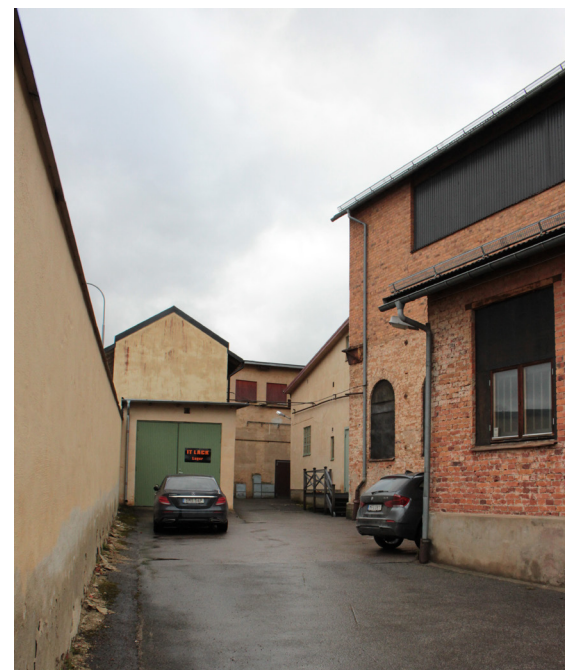
Fasad mot norr (med grön port bakom bil).
