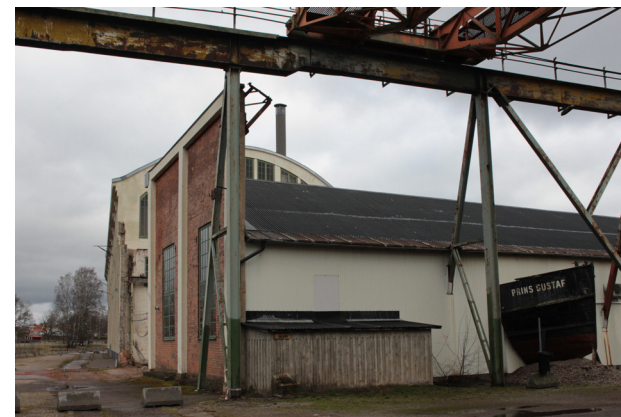
Fasad mot söder samt "kulissfasaden" mot väster.
