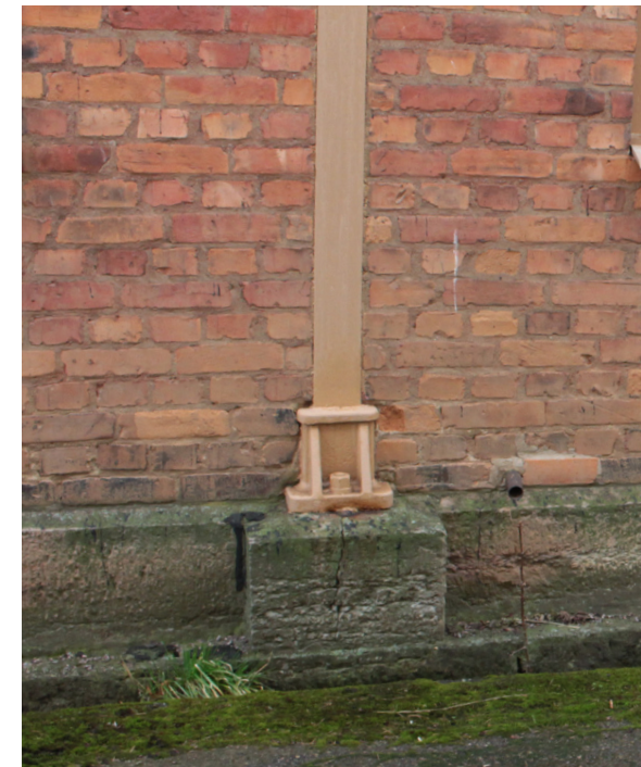
Utvändigt exponerad pelar-balkkonstruktion som i olika varianter är typisk för Motala verkstad.
