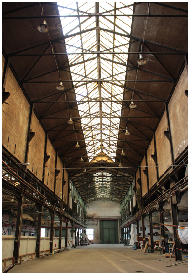
Det högresta skeppet med den långsträckt taklanterninen i byggnad 4 är ett av de mest karaktärsskapande inslagen i plåtverkstadsgruppen.
