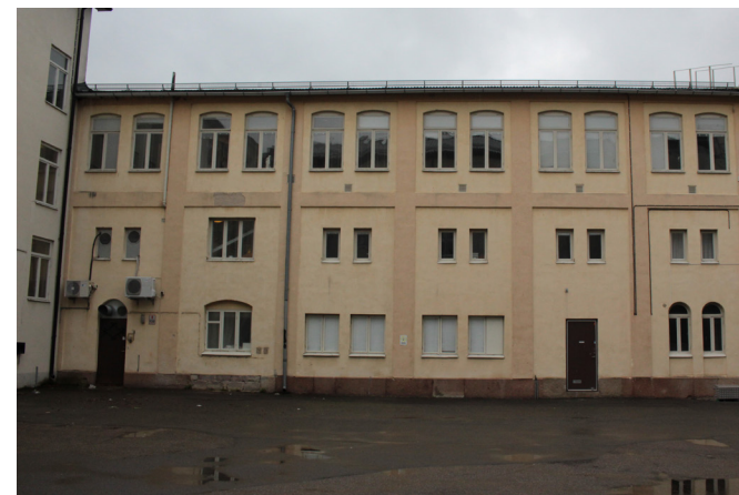
Byggnad 10, östfasaden in mot Borggården.
