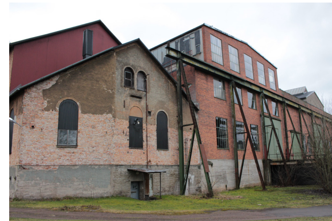
Gjuteriets norra gavel. Den lägre delen tillhör den ursprungliga byggnaden innan ombyggnad.
