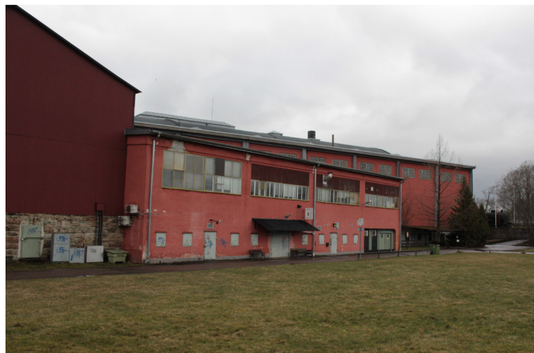
Sjukhusverkstaden sedd från öster.
