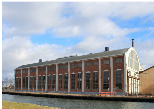
Lokhallen från sydväst. Notera att södra gaveln är synlig pga att muren framför byggnad 17 tillfälligt rasat.
