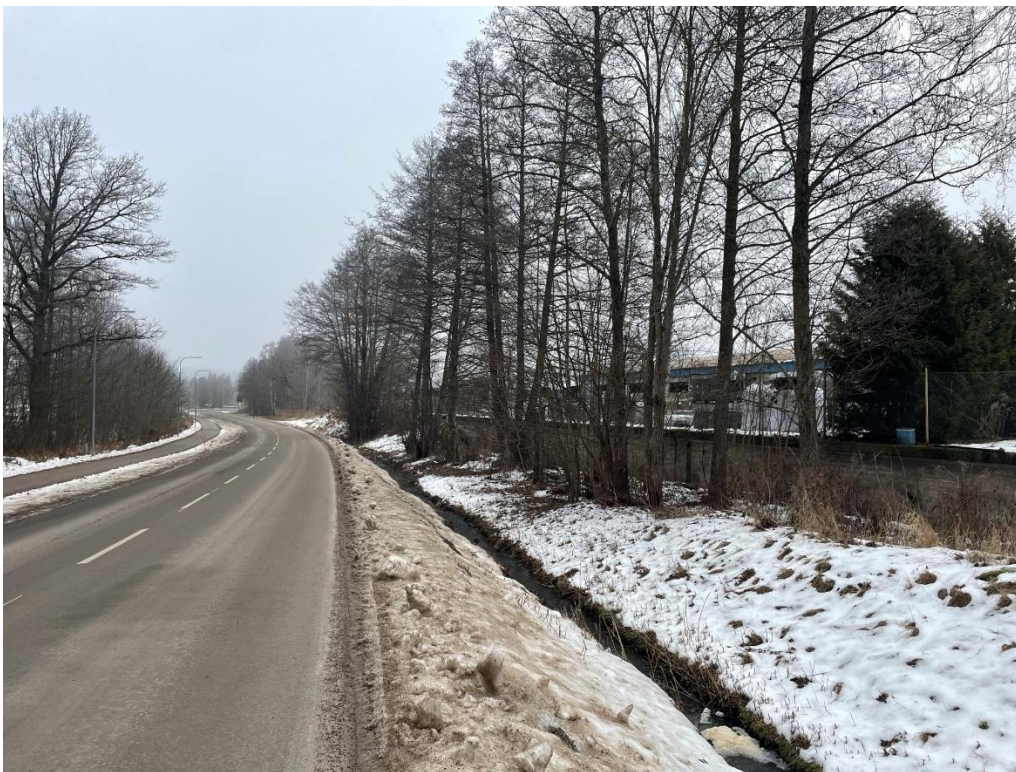
Figur 12 - Här syns de södra delarna sett från Skänningevägen, här löper en stödmur. Bilden tagen 260120.
