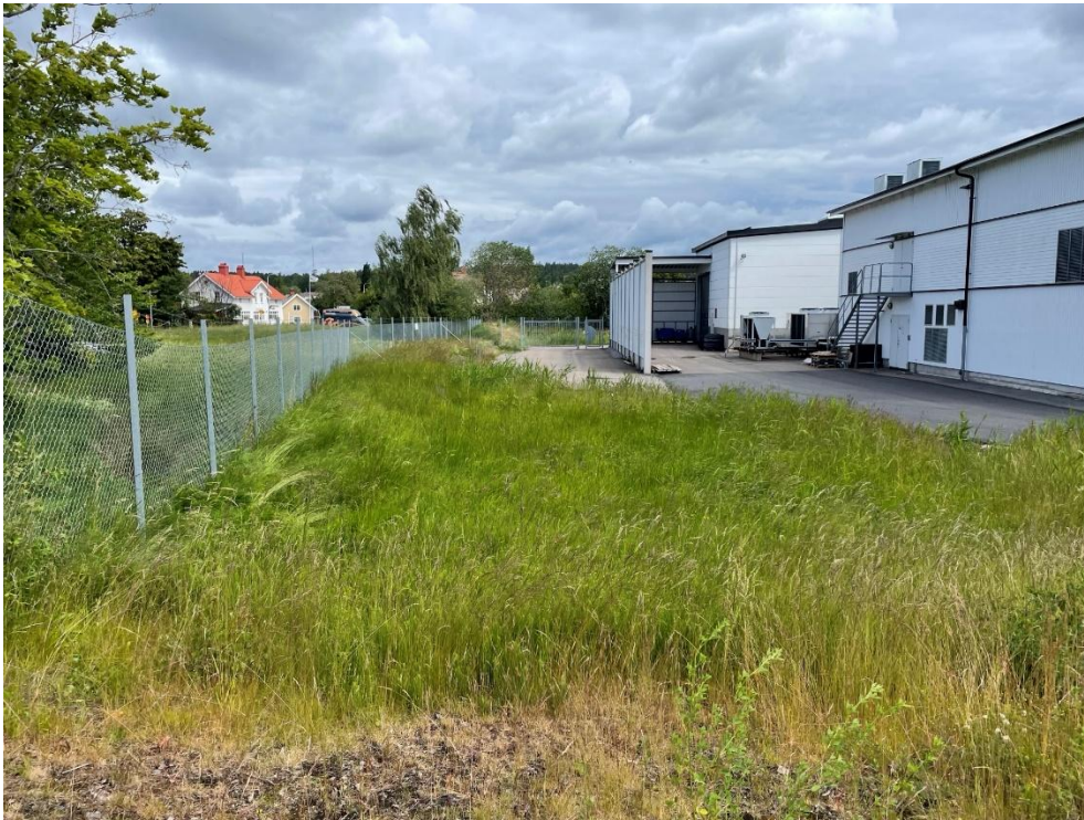
Figur 7 - Slänt i anslutning till ett dike i nordväst, väster om fabriksbyggnaden. Bilden tagen från söder, 250524.
