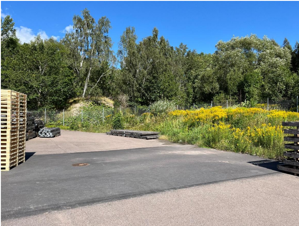
Figur 10 - Slänt i belägen i områdets sydöstra delar. Slänten benämns [8] i Figur 2. Bilden tagen 250812.
