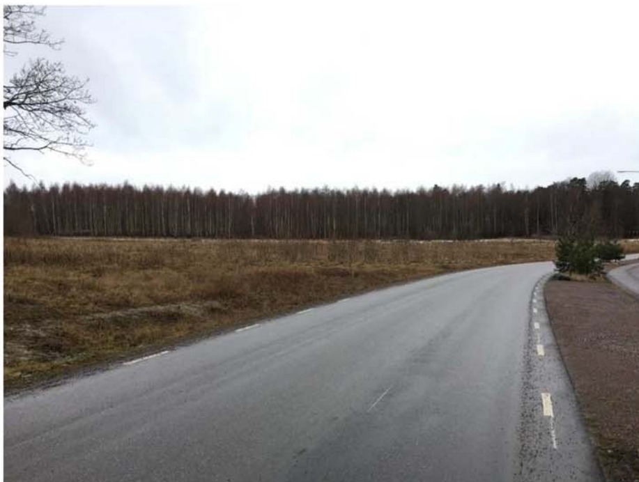
Figur 10: Foto från Badstrandvägen ner mot bebyggelsen längs med Varamovägen.
