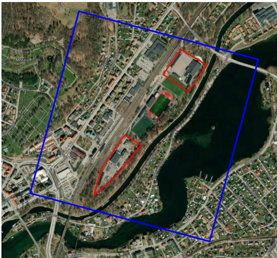
Figur 8. Kvadratkilometer (blå ruta) som analyseras för samhällsrisken. Ungefärlig placering av etapp I och II utmarkerat i rött
