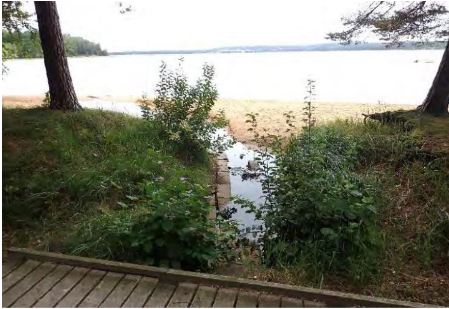
Figur 4. Stensatt utloppsdikey. (Vatten och Samhällsteknik, 2018)
