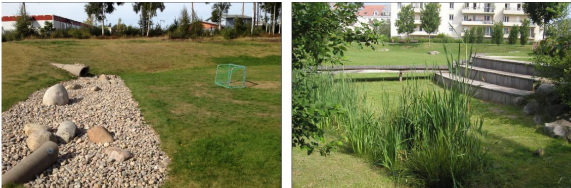
Figur 13.2-1 Exempel på torr damm och hur de har integrerats i landskapet (Bildkälla: Svenskt Vatten, 2019).
