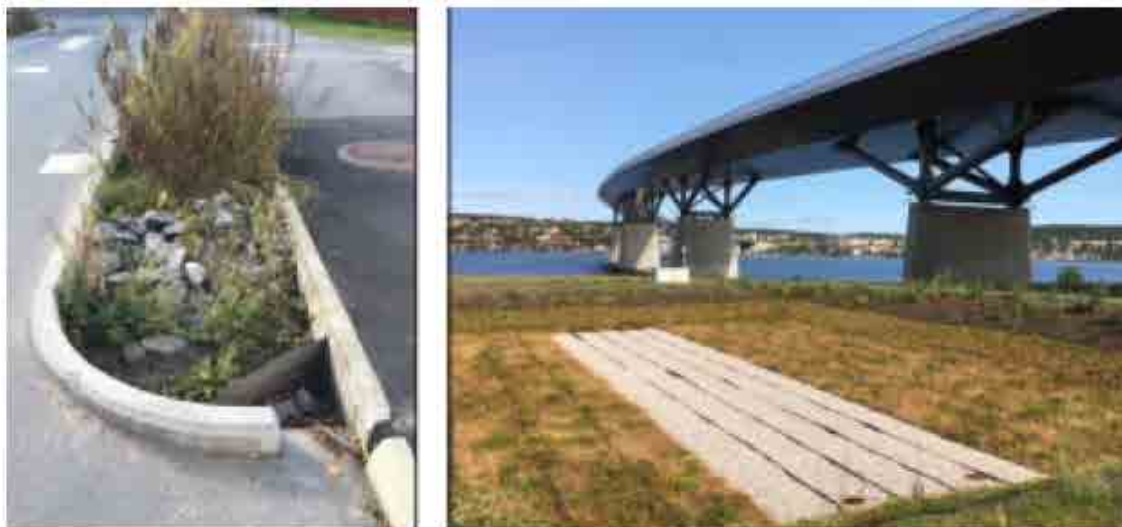
Figur 9. Biofilter i olika storlekar. Larm, T. Blecken, G. Rapport Nr 2019-20, Svenskt Vatten Utveckling.
