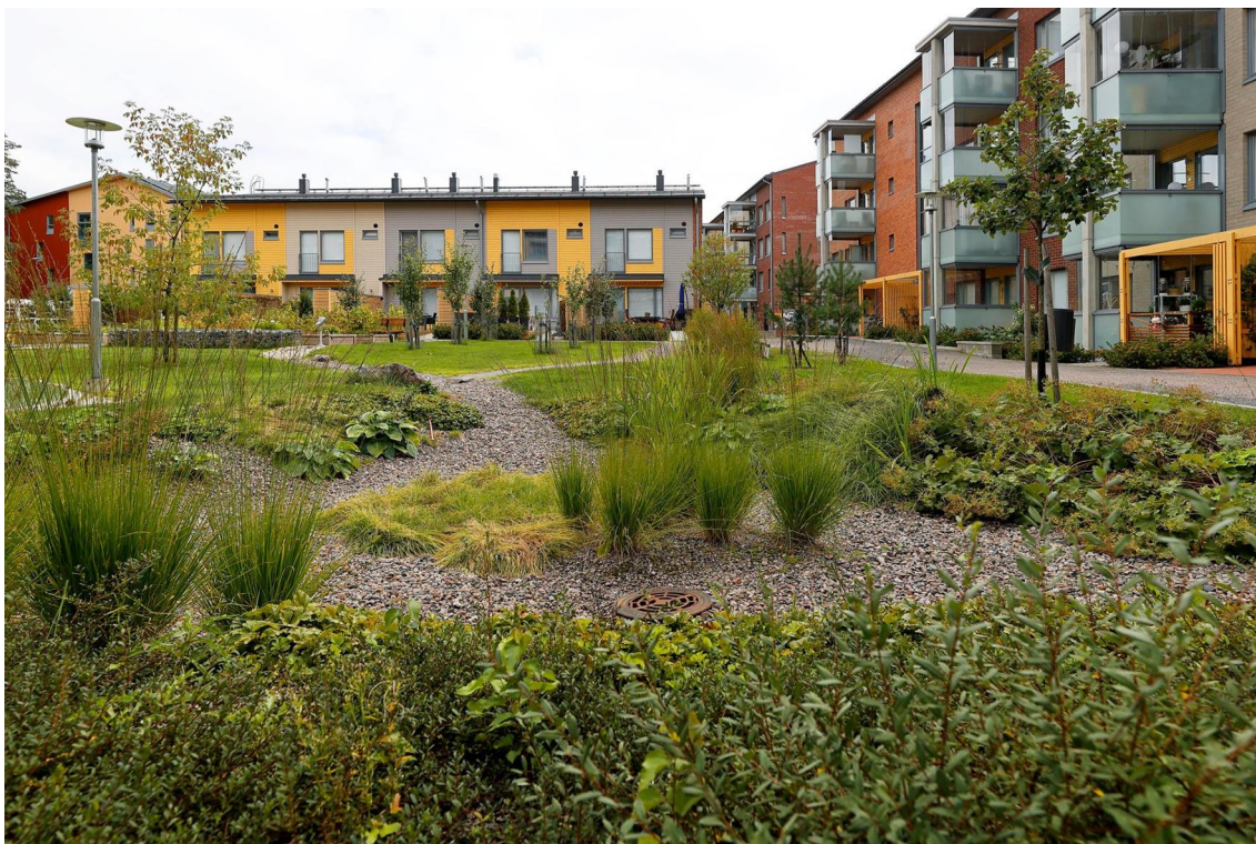
Figur 19 - Biofilteranläggning/Regnträdgård med planteringar med växtbäddar och krossmaterial (HSY, 2024).
