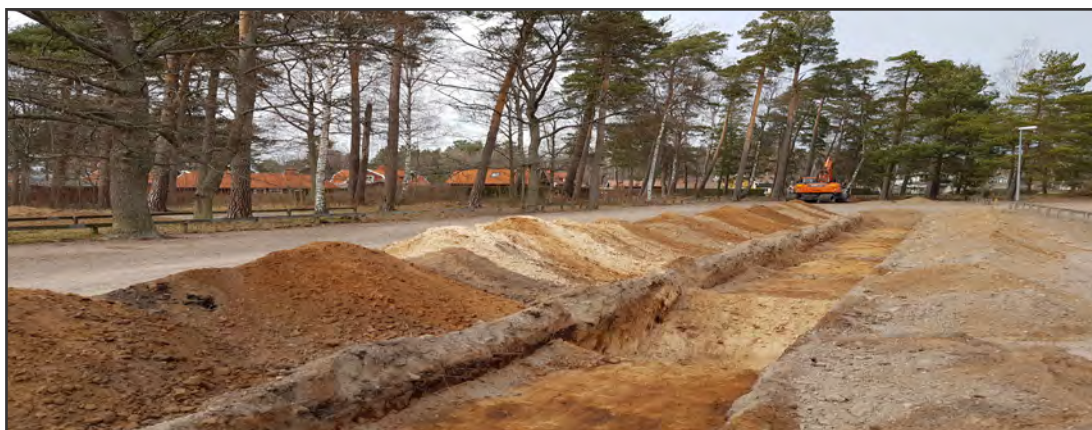
Figur 3. Sökschakt inom Sweco 002. Materialet under pakreringsytan utgjordes av sand.
