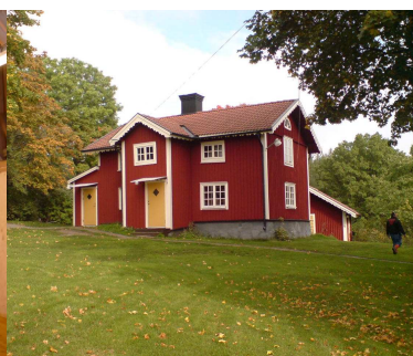
Inne i Mangårdsbyggnaden finns både kök och sällskapsrum
